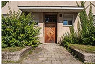
Einer der Hauseingänge des Gebäuderiegels entlang der Wendl-Dietrich-Straße.
