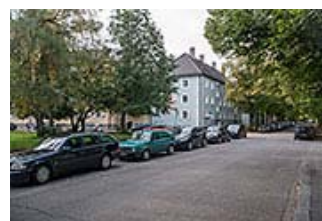
Ab der Hawartstraße sind dreigeschossige Wohnblöcke den Innenhöfen vorgelagert und grenzen diese zur Nibelungenstraße hin ab.
