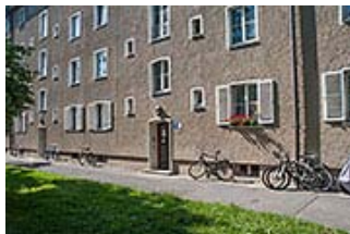
Die einem Innenhof zugewandte Ostfassade eines der Blöcke. Die Fassaden und Eingänge sind schlichter ausgeführt als bei Bauabschnitt Süd, die Fenster sind kleiner.
