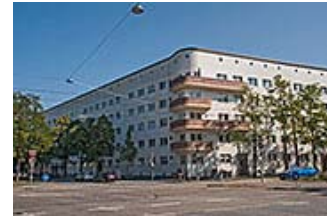
Der Amerikanerblock am Steubenplatz, Ansicht der Südwestecke und der Westfassade von Südwesten.
