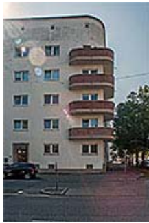
Nordwestecke des Amerikanerblocks mit einem Teilausschnitt der Nordfassade.
