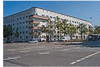
Der Amerikanerblock am Steubenplatz, Ansicht der Südfassade von Südwesten.
