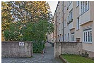
Die Nordseite bzw. Rückseite des entlang der Wendl-Dietrich-Straße verlaufenden Gebäuderiegels. Die Wohnungen haben hier teilweise verglaste Loggien. Dieser Hinterhof wird von einer Mauer zur Opferdingenstraße hin abgegrenzt.
