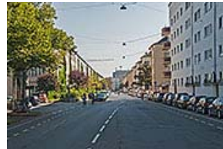
Die Wendl-Dietrich-Straße ist die von Osten nach Westen verlaufende Hauptachse, die durch die Siedlung führt und weiter zum Rotkreuzplatz. Nördlich der Straße steht ein von Durchfahrten durchbrochener Gebäuderiegel mit Nord-Süd-orientierten Wohnungen, südlich der Straße stehen 12 Gebäuderiegel, von Norden nach Süden verlaufend, deren Wohnungen Ost-West-orientiert sind. Wegen ihrer Anzahl werden diese 12 Gebäuderiegel auch die 'Zwölf Apostel' genannt.
