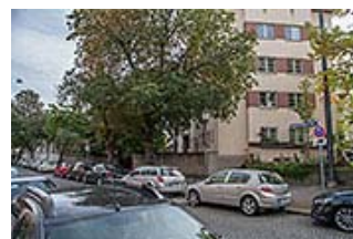
Das westliche Ende des Gebäuderiegels an der Arnulfstraße, am Amerikanerblock, von der Einmündung der Karl-Schurz-Straße in die Arnulfstraße aus gesehen.
