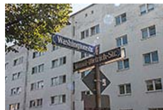
Blick auf die Nordfassade des Amerikanerblocks. Anders als die übrigen Seiten zeigt die Nordfassade gliedernde vertikale Einschnitte. Auch die Gestaltung der Hauseingänge weicht auf der Nordseite von der der übrigen Seiten ab.
