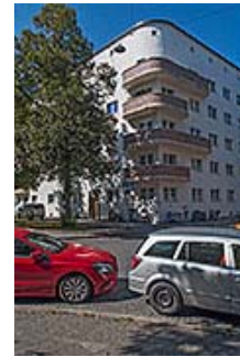
Südostecke des Amerikanerblocks mit den typischen ausgerundeten, mit Klinker verkleideten Balkonen. Standort der Aufnahme ist die Einmündung der Gotelindenstraße in die Karl-Schurz-Straße.
